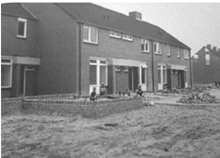
De Dennenhoven in aanbouw.
